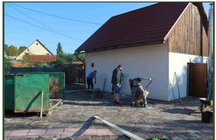
Stavební práce na moštárně
